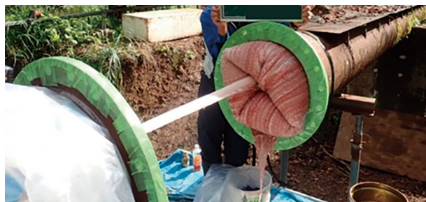
写真5 反転状況（排泥管撤去部）
