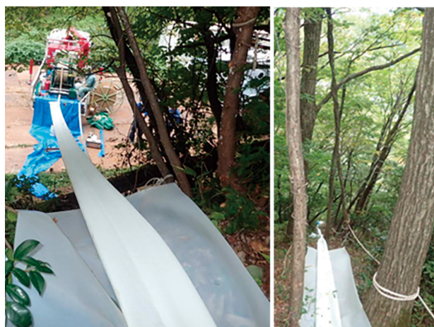
写真4 到達側ベルト引き取り状況
